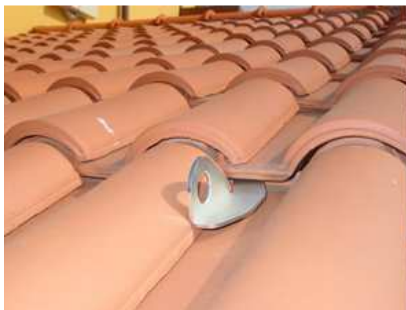
ANCORAGGIO UNI EN 795 CL. A2 (solo per tetti inclinati)
