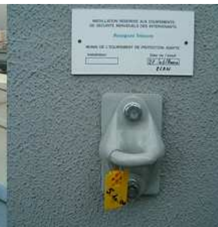
ANCORAGGIO UNI EN 795 CL. A1 (su superfici con qualsiasi inclinazione)
